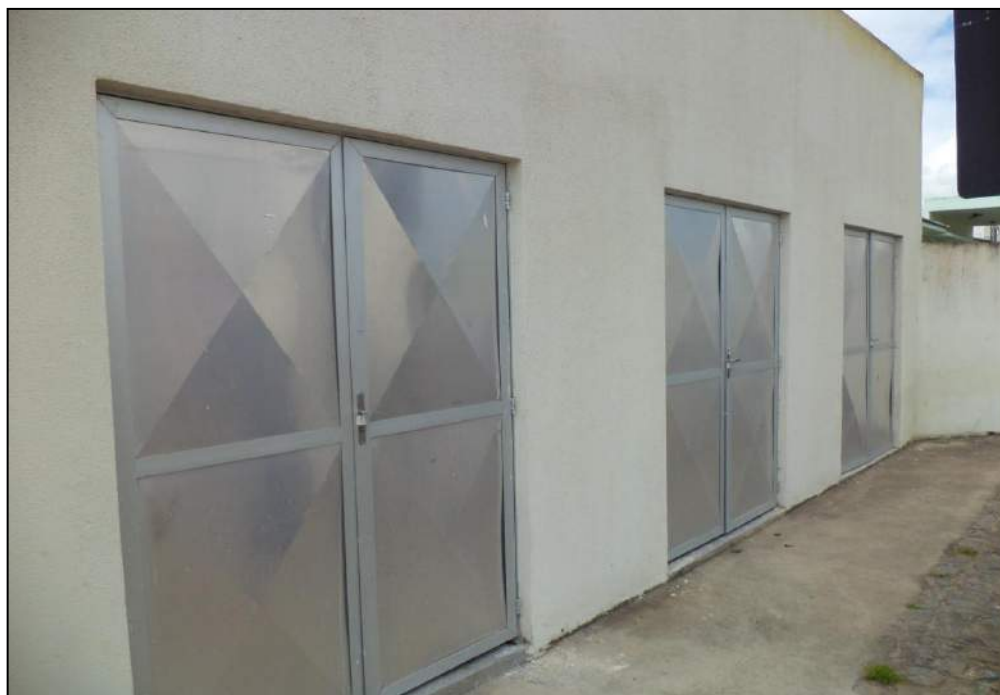
Figura 57: Abrigo temporário de RSS com três compartimentos – Itabaiana/SE. Crédito fotográfico: M&C Engenharia/2013.
