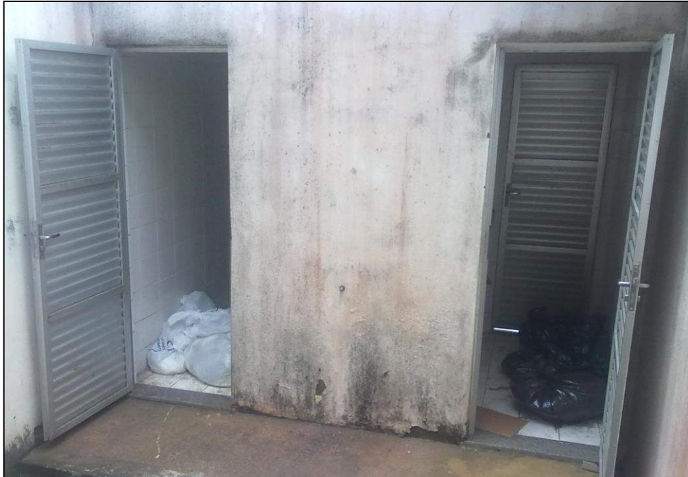
Figura 61: Abrigo temporário de RSS com dois compartimentos – Malhador/SE. Crédito fotográfico: M&C Engenharia/2013.
