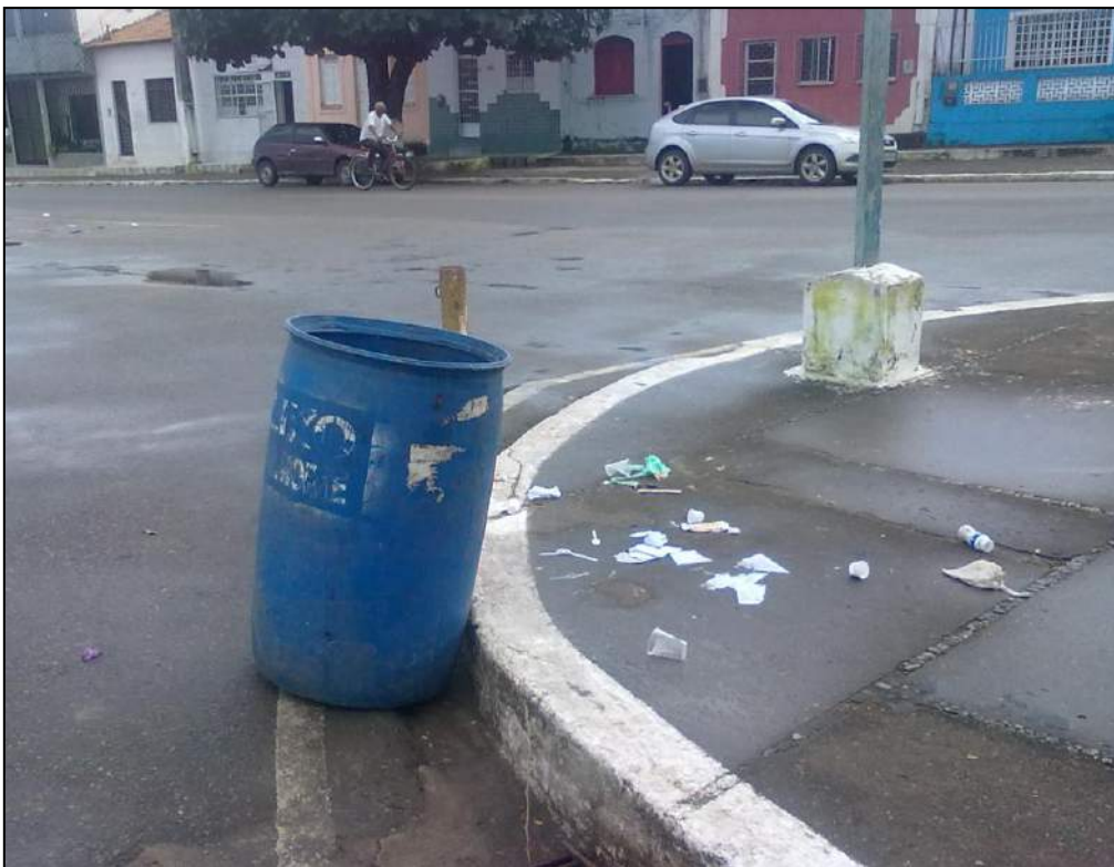
Figura 47: Coletor móvel (tambor) – Divina Pastora/SE. Elaboração: M&C Engenharia/2014.
