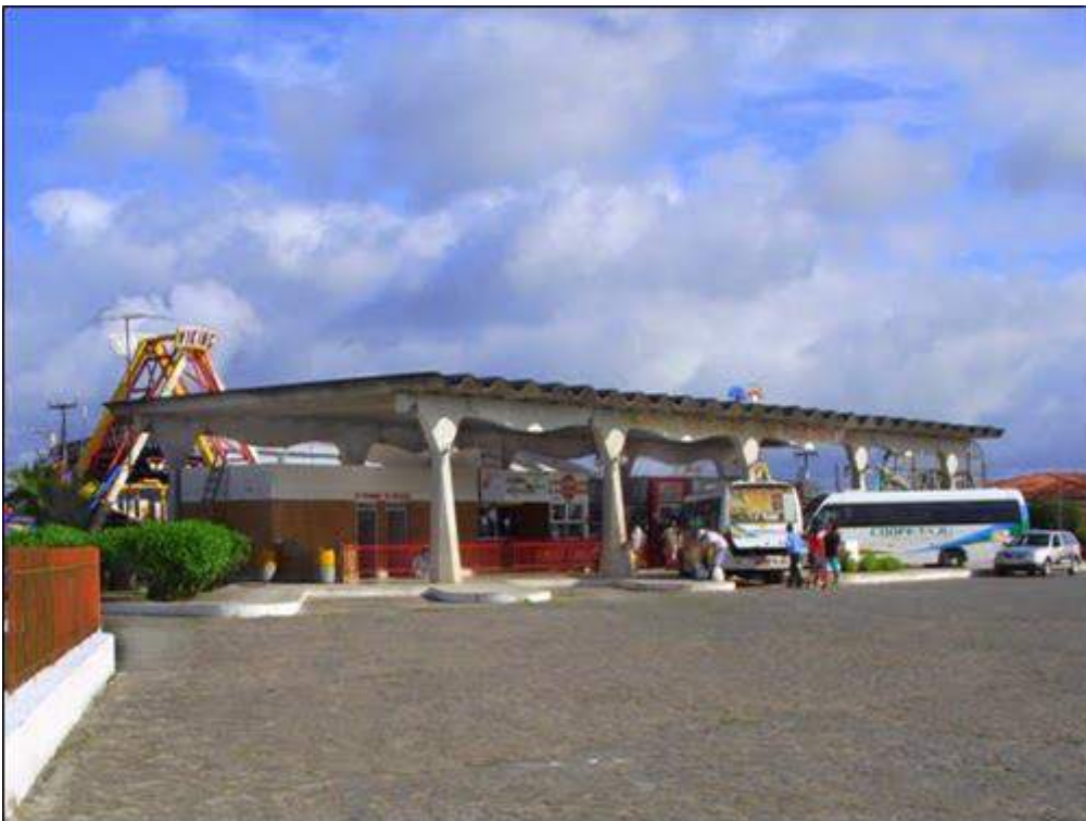
Figura 71: Terminal Rodoviário da cidade de Nossa Senhora das Dores.
